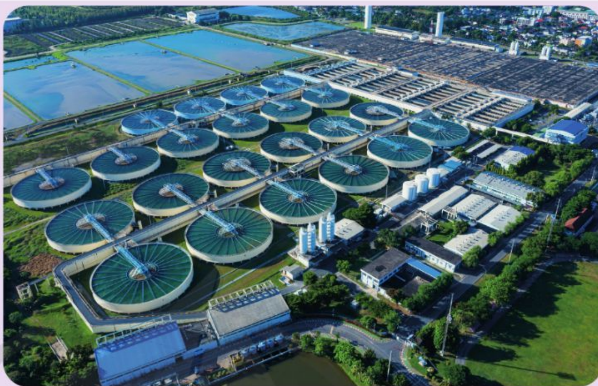
Các bể chứa nước trong nhà máy xử lý nước có diện tích bề mặt lớn để nước tiếp xúc nhiều với không khí
